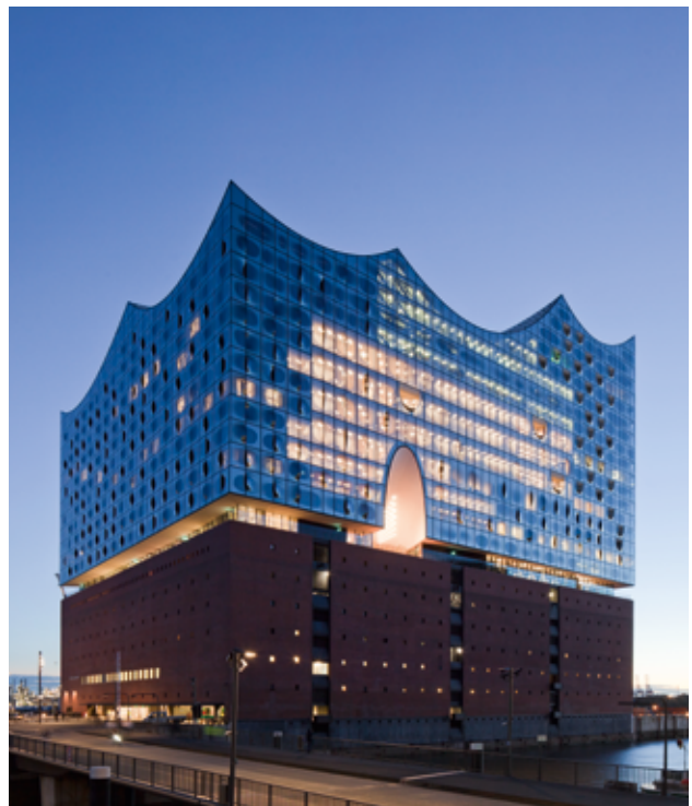
Elbphilharmonie Hamburg: TROX Raumlufttechnik in allen Konzertsälen
