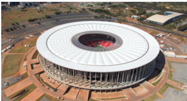
Estádio Nacional, Brasília: TROX Raumlufttechnik in allen neu errichteten WM-Stadien in Brasilien
